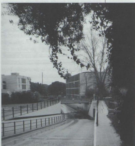
Problema «etern» els que circulen per sota del pont de la via estem farts de patir el problema de l'aigua que brolla del terra i dels continus forats «trencacotxes» i el perill d'accidents en general.
